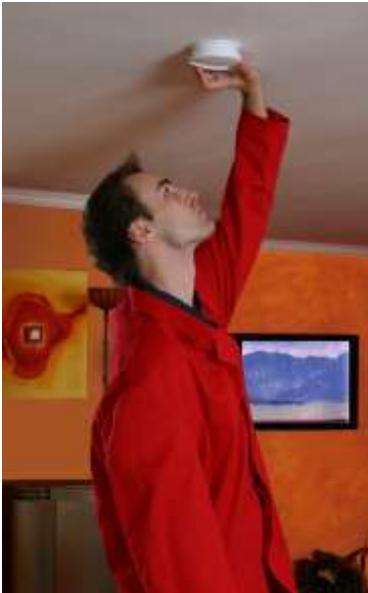
Kompetente Ansprechpartner rund um den vorbeugenden Brandschutz sind die qualifizierten Brandschutz-Fachbetriebe
